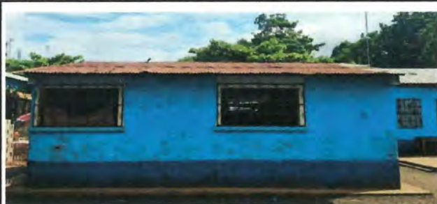
Foto 7: Reparación, repello y cernido de paredes
