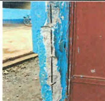
Foto 8: Reparación, repello y cernido de paredes
