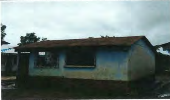
Foto 1: Sustitución de lámina, por lámina troquelada Calibre 26 (Módulo I)
