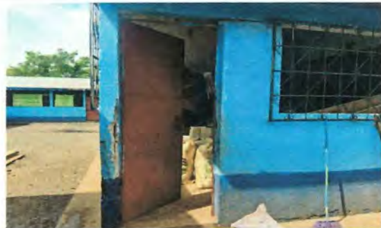
Foto 9: Reparación, repello y cernido de paredes
