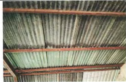
Foto 4: Sustitución de estructura de soporte de metal, por metal Módulo II
