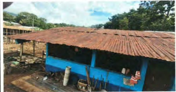
Foto 2: Sustitución de lámina, por lámina troquelada Calibre 26 (Módulo II)
