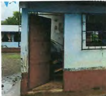
Foto 5: Sustitución de puerta de metal
