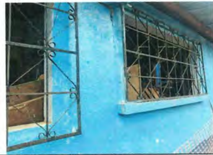
Foto 6: Sustitución de balcones de metal
