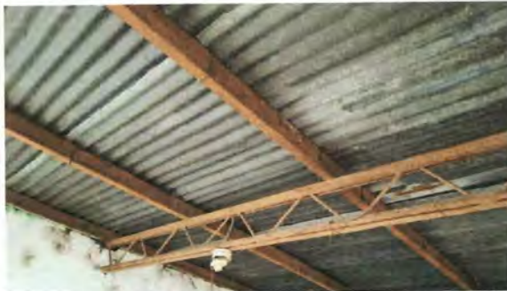
Foto 3: Sustitución de estructura de soporte de metal, por metal Módulo I
