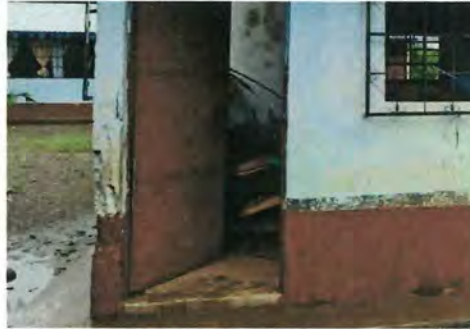
Foto 10: Pintura en muros exteriores e interiores
