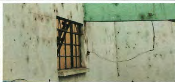
Foto 12: Reparación de paredes
